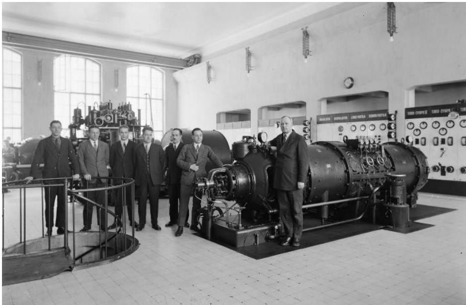
A. Ahlström Osakeyhtiön voima-aseman konesali, henkilökuntaa kokoontuneena Stal ja AEG -turbiinien ympärille 1926.
